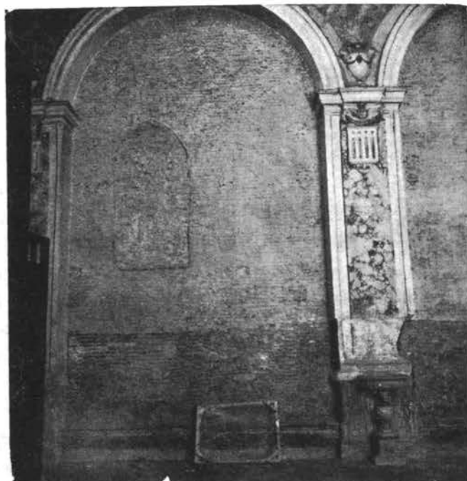
Fig. 74 — Muro sinistro della nave.
